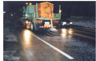
凍結防止剤散布状況
