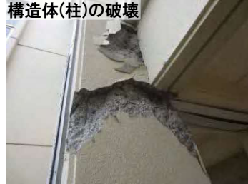
構造体(柱)の破壊
