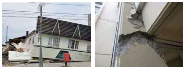
【H30年度北海道胆振東部地震 被害状況写真】
