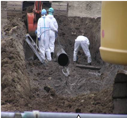
農業用水路（パイプライン） 交換工事の状況
