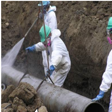
石綿が飛散ないように 水をまきながら作業を行います。
