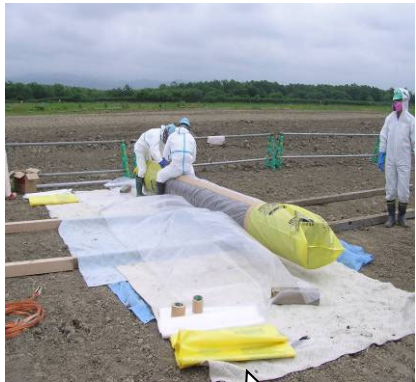
撤去した資材は、処理場までの 運搬中に石綿が飛散しない ようにビニールシートで梱包 して運びます。
