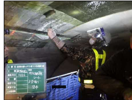
写真④ 剥落防止工事 (忠別清水線<新得町>)
