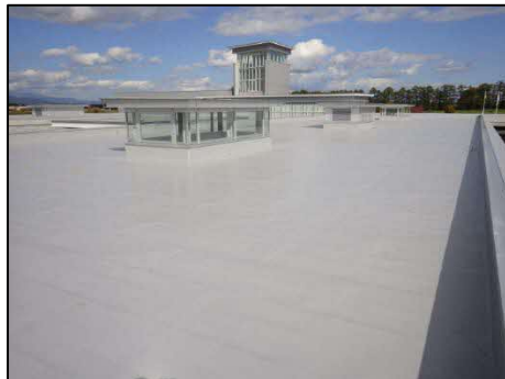
写真③ 屋上防水改修工事 (酪農試験場研究庁舎<中標津町>)
