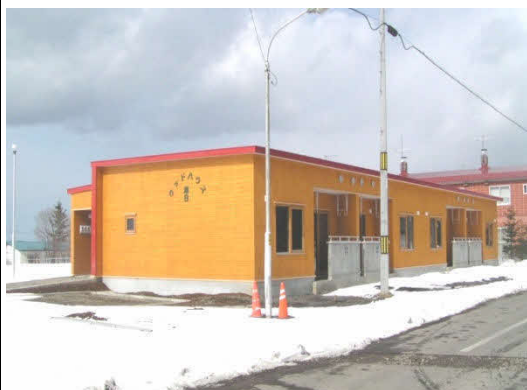
木造公共施設（共同住宅）
