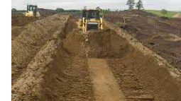
ブルドーザによる基盤切整
