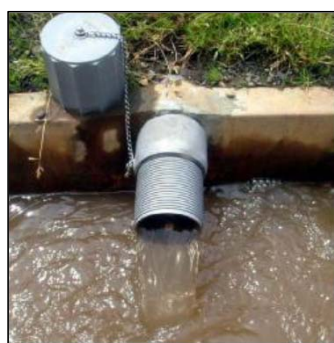
写真1 キャップ式水閘
