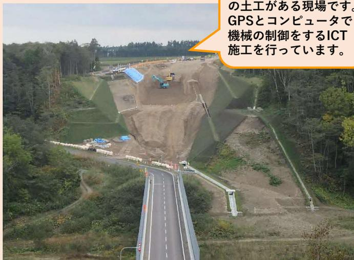
事業総計で約20万m<sup>3</sup>の土工がある現場です。GPSとコンピュータで機械の制御をするICT施工を行っています。
