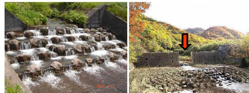
落差工に設置された魚道 (白井川、尻別川水系、後志管内)      スリット化された砂防ダム (折川、後志管内)
