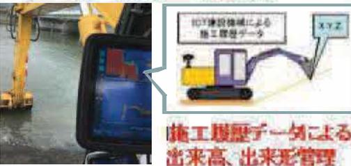
ICT建設機械による施工履歴データによる出来高、出来形管理
