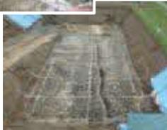
設計図に合わせた施工範囲、区割り等の測量及び目印設置
