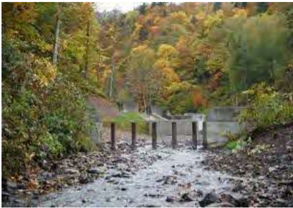
R型流木捕捉式治山ダム
