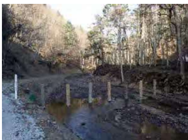
丸太差込式流木補足工
