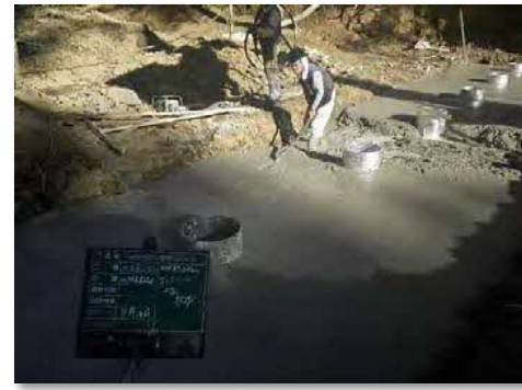
生コン打設+養生
