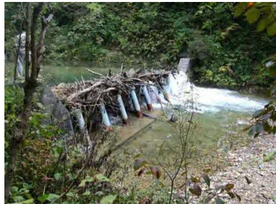
A型流木捕捉式治山ダム
