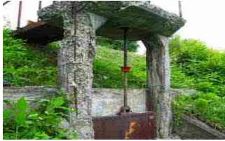
▼河川管理施設 (樋門)
