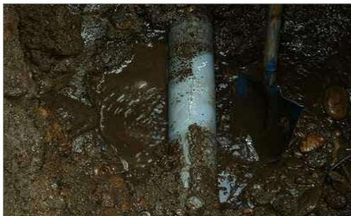
老朽化による配水管の漏水
