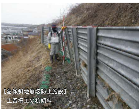
写真 2-2 砂防関係施設の損傷・劣化の状況
