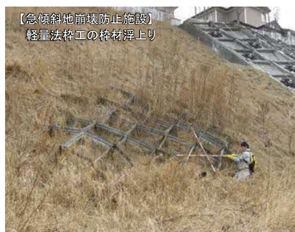
写真 2-2 砂防関係施設の損傷・劣化の状況
