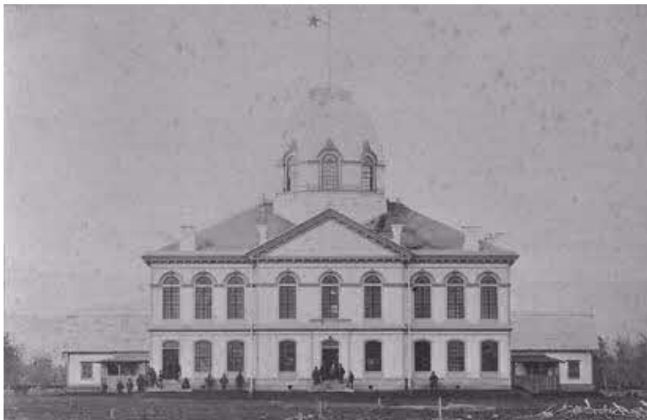
資料 20 完成した開拓使札幌本庁本庁舎(北海道大学附属図書館北方資料室所蔵)
