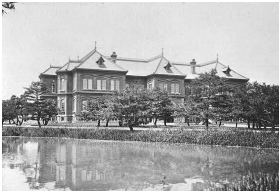
資料 26 火災復旧後の赤れんが庁舎(北海道大学附属図書館北方資料室所蔵)
