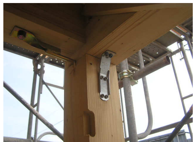
写真 3.3 柱頭部の接合金物と梁の引寄せ金物
