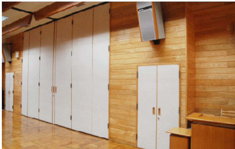
林産試験場講堂の内装材として使用 (難燃処理を施した羽目板)
