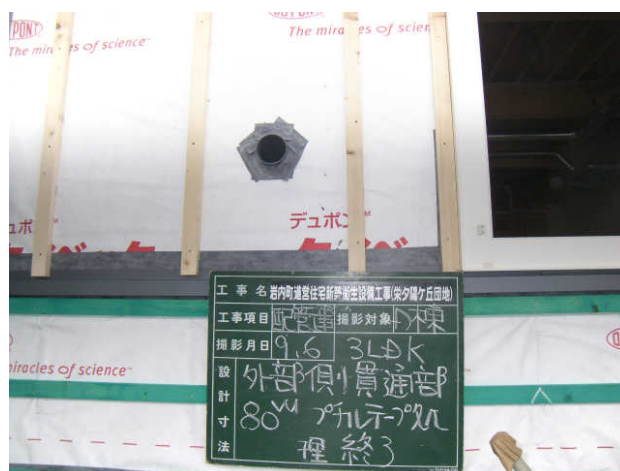
写真 3.6 換気スリーブ貫通部処理と通気層(縦胴縁)
