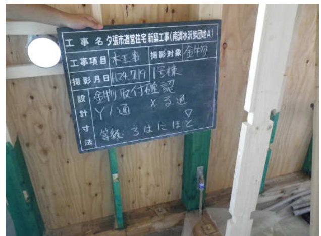
写真 3.2 土台のアンカーボルトと柱脚部のホールダウン金物の施工状況
