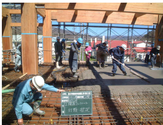
写真 2.3 鉄筋コンクリート造床スラブの施工
