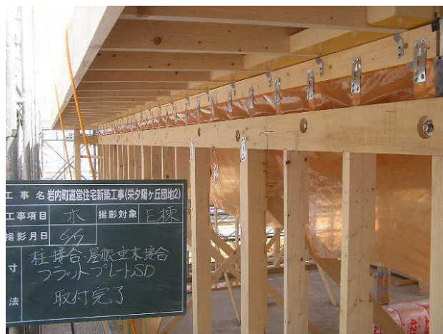
写真 3.4 柱頭部接合金物と先張り防湿気密フィルムの施工状況
