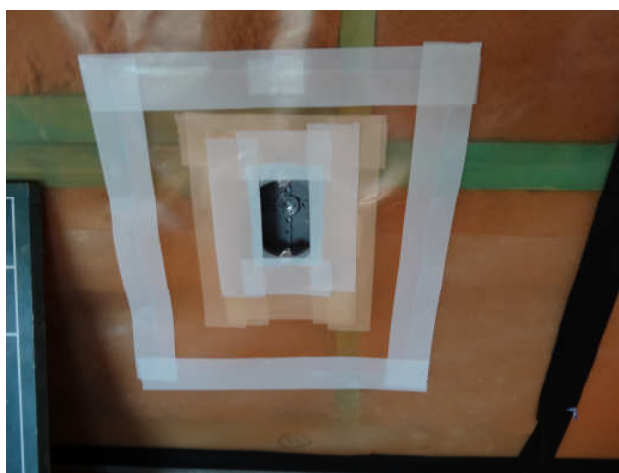
写真 3.5 防湿気密型コンセントボックスの施工状況
