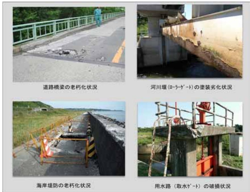
図6 道が管理するインフラの老朽化状況
