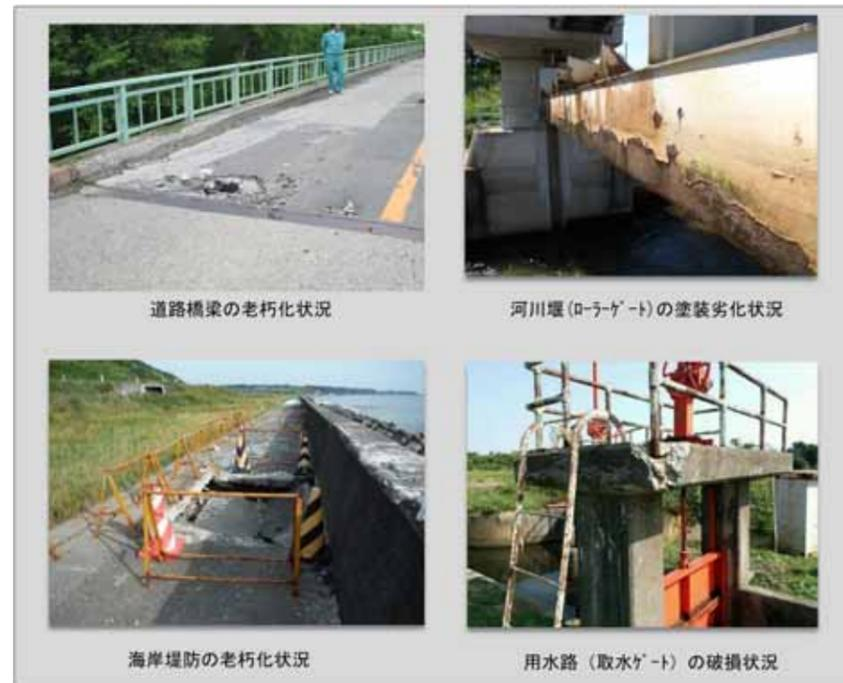
図6 道が管理するインフラの老朽化状況
