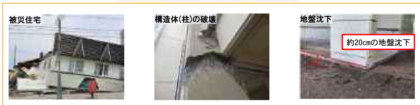
【平成30年北海道胆振東部地震 被害状況】
