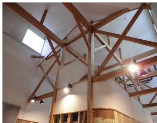
▲現在工事中のサテライトオフィス
