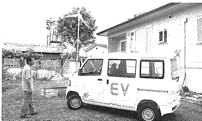
羽幌町天売支所の敷地内に設置された風力発電機と電気自動車
