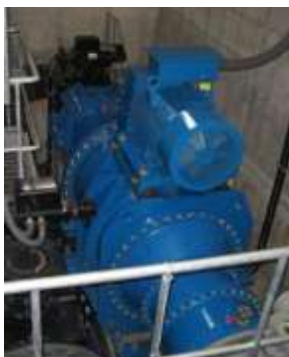
横浜市水道局ホームページより
