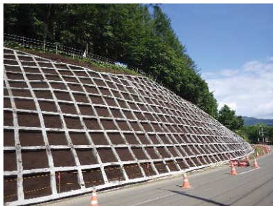
<対策例>法枠工
