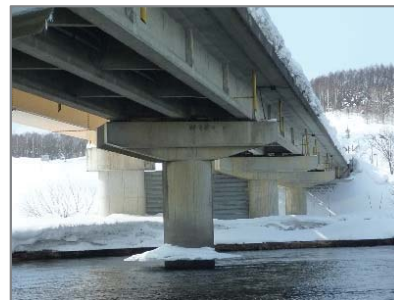
橋梁の耐震補強対策
