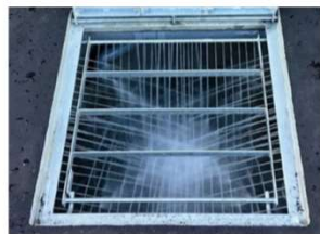
1時間で中型タンク(4t)1台分 (新雪換算約5㎡)を融かす能力
