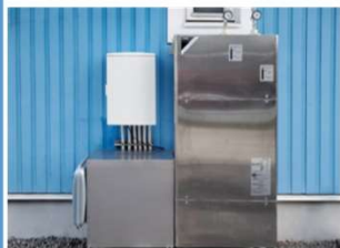
切替バルブ・フリークーリング循環ポンプ等を収納するBOXを追加
