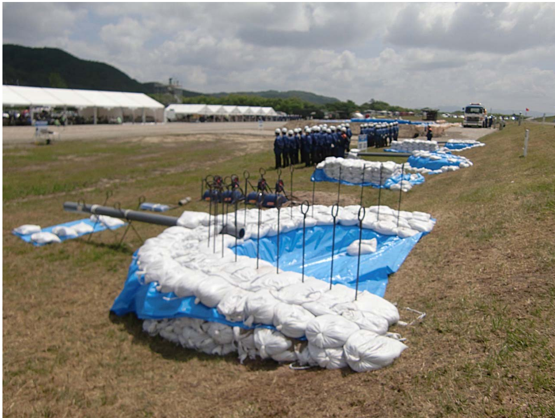
写真 3-6 ゆうばり 夕張川(長沼町) 水防訓練における堤防からの漏水*を軽減する「月の輪工*」 実施状況
