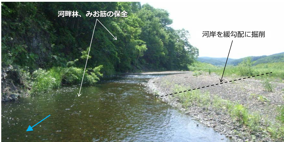
写真 3-1 隈川(北見市) 河畔林、現況のみお筋を保全し、河岸を緩勾配に掘削した事例
