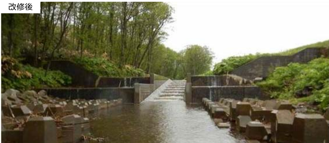
写真 3-12 ペンケオポツペ川(幌延町) 落差工の改修により連続性を確保した事例
