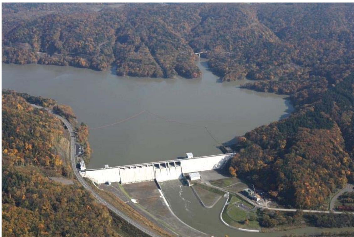
写真 3-8 とろべつ 当別ダム(当別町) 治水や利水(水道・かんがい)等の複数の機能をもつ 多目的ダム *
