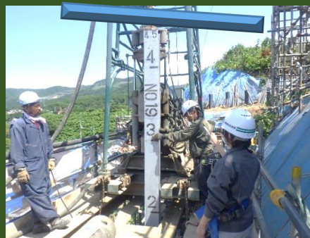
↑急傾斜地工事の立会確認の様子 (H形鋼杭打設状況)
