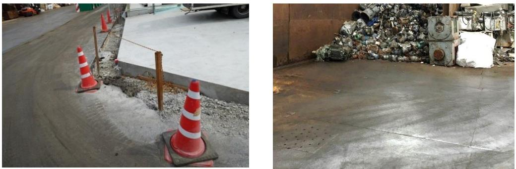
(左：ヤード床面はコンクリート（350mm）で舗装。写真は工事中のもの)
