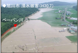
◆旭川市 浸水被害(H30.7)
