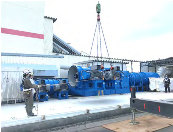
坑内換気設備の更新
