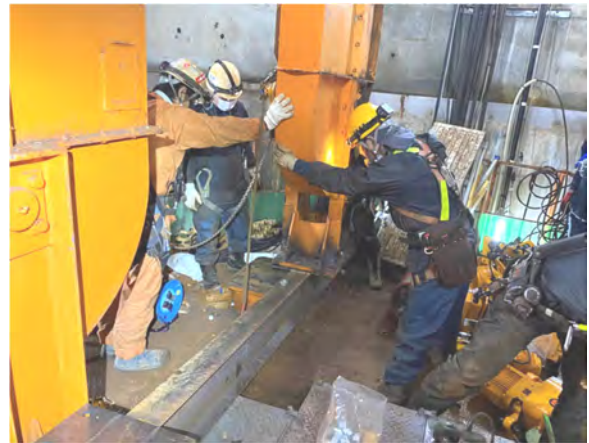
東立坑スcaffoldingの更新
