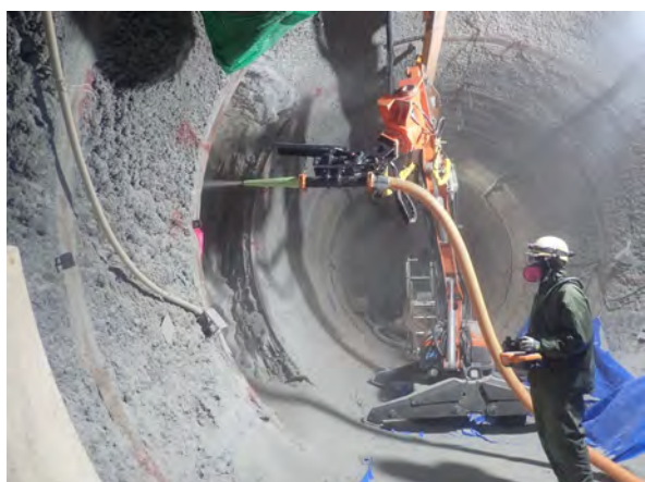
吹付け作業の状況
