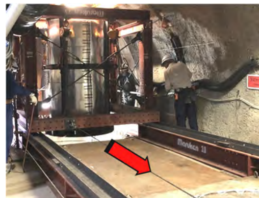
門型架台ごと一体試料を取り出し
