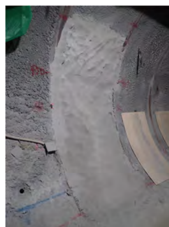
切欠き部の吹付け完了
