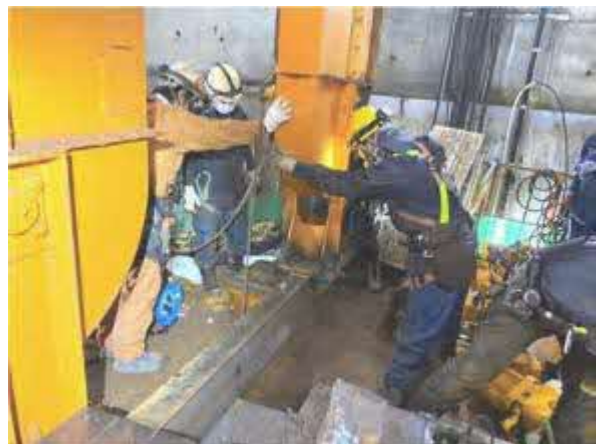
(b) 東立坑スカフォードの更新
