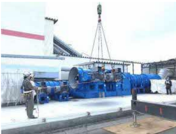
(a) 坑内換気設備の更新
