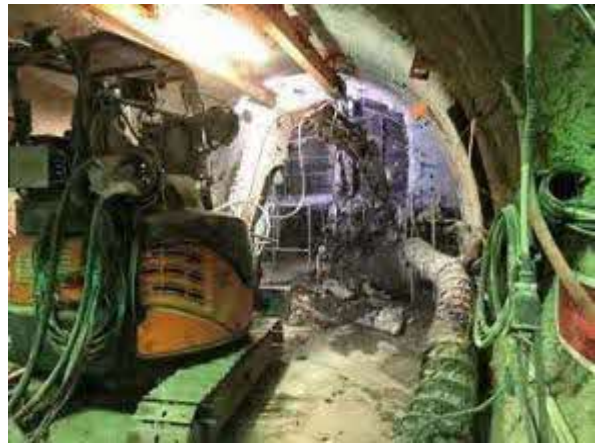
(b) プラグの解体・撤去
