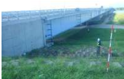
調査地点全景
