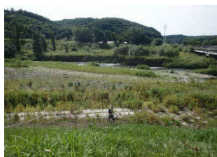
調査地点全景
