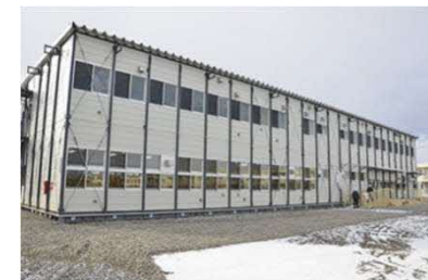
早来中学校仮設校舎(安平町)
