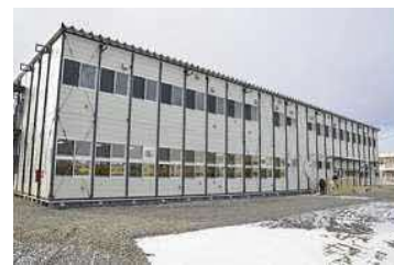
早来中学校仮設校舎(安平町)
