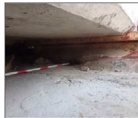
写真 支承部損傷箇所
