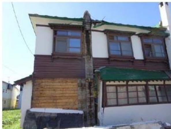
(b) 煙突の倒壊
