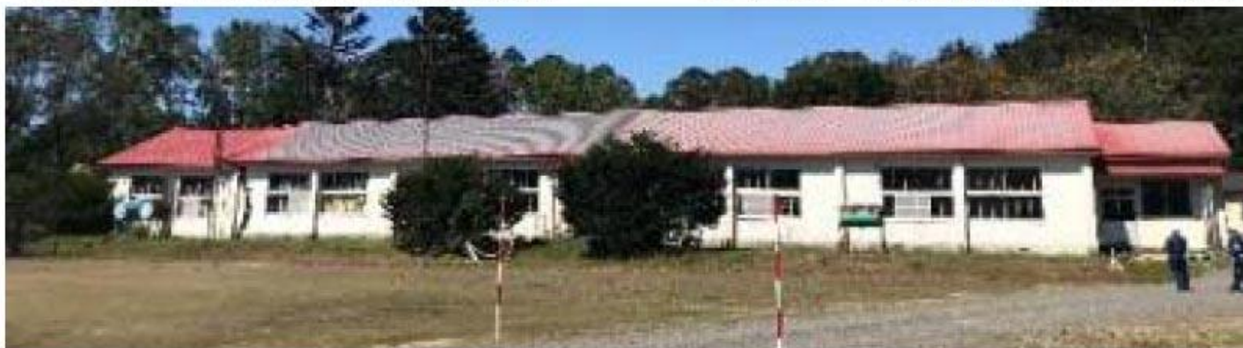
写真 5.2.3 旧小学校の校舎 A 全景
