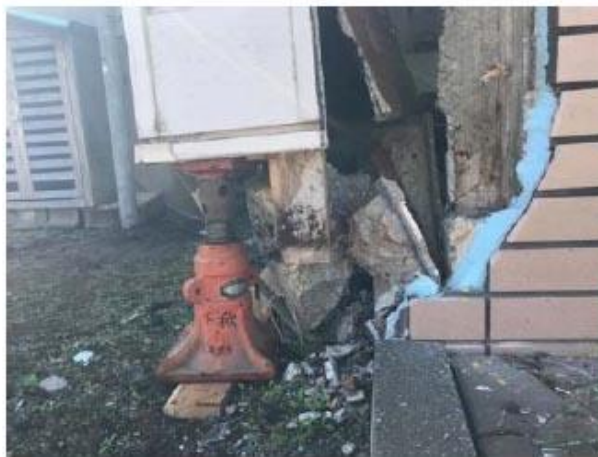
(b) ジャッキによる支持
