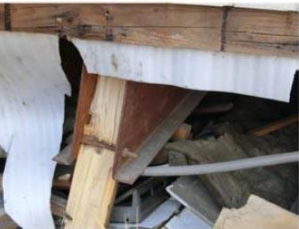
(d) 2階床を支持する鋼材
