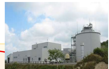
廃棄物由来のバイオガス活用（稚内市）
