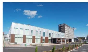
公共施設の機能集約と新機能を付加したまちなか拠点。官民連携の事業手法で整備（室蘭市）
