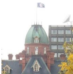
現在（改修工事前）
