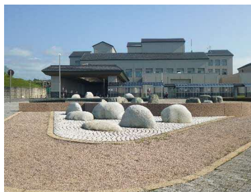
〈江差病院外観〉
