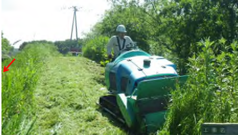
(堤防除草 作業状況)
