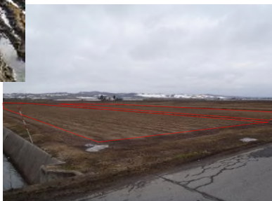
整備前の小区画ほ場
