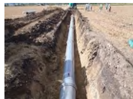
パイプライン化後の用水路
