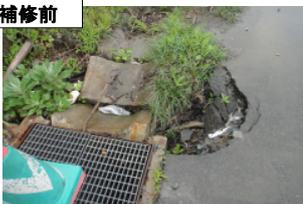
日常点検により、破損した排水枦の蓋と道路舗装を確認。車両脱輪事故等が懸念されるため、漁港管理者によりすみやかに少額工事を発注
