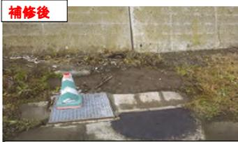
破損した排水枦の蓋を交換し、破損した舗装部分を再舗装を実施し、漁港機能の低下を防止
