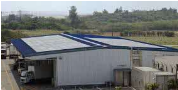
貨物棟屋根に設置された太陽電池
