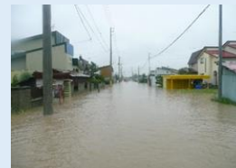
治水・砂防・海岸施設の整備
