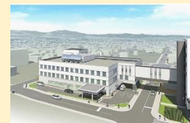
地方・地域センター病院の整備
