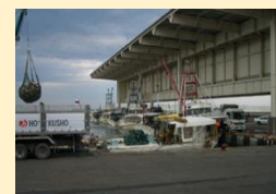
荷さばき施設など水産施設の整備
