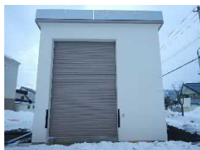
建屋:床面積 99.28㎡ 構造 RC造
