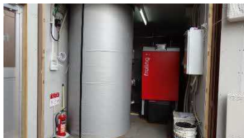
←コンテナ内部 (ボイラーFröling社製、 50kWボイラー、 貯湯タンク)
