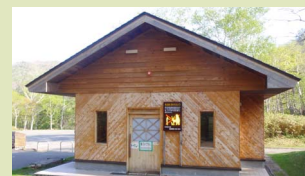
野営場内トイレ
