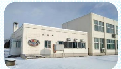
〔写真〕 施設外観
