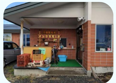
[写真] 施設外観
