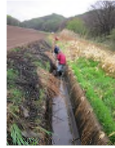
(用水路の土砂上げ作業)
