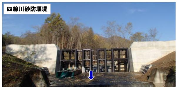
施設効果量 土砂量32,000m<sup>3</sup>、流木量1,300m<sup>3</sup>
