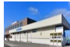
集出荷・貯蔵・加工施設の整備
